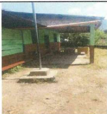
Foto 3: Mejoramiento de torta de concreto corredor aula debido al mal estado de la misma.
