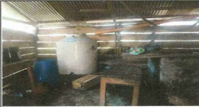
Foto 7: Mejoramiento de pared de madera por block formal, repello y pintura para area de cocina.
