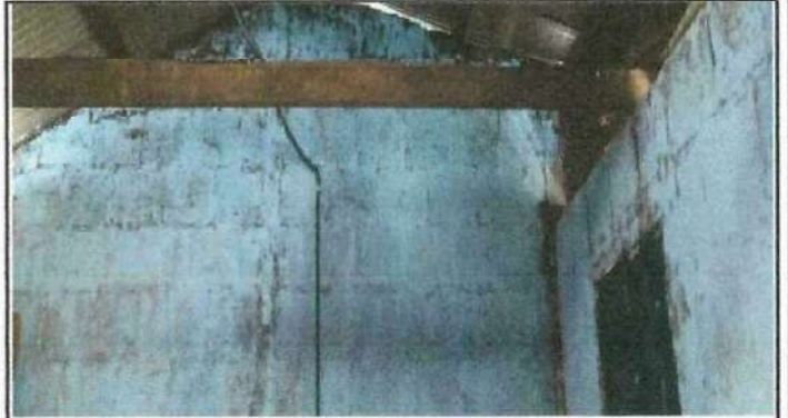
Foto 8: Mejoramiento de pared block formal, repello y pintura para area de cocina.
