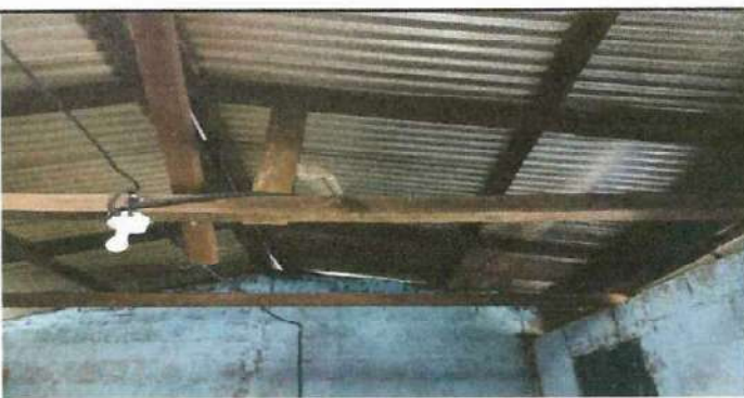
Foto 5: Sustitución de estructura de madera por metal en area de cocina y aula, para mayor durabilidad de la misma.
