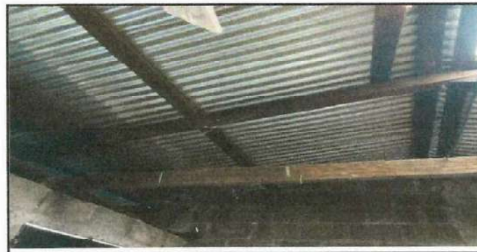
Foto 6: Sustitución de estructura de madera por metal en area de cocina y aula, para mayor durabilidad de la misma.
