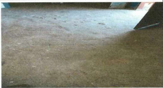
Foto 1: Instalación de piso cerámico en aulas y dirección, debido al mal estado de torta de concreto.
