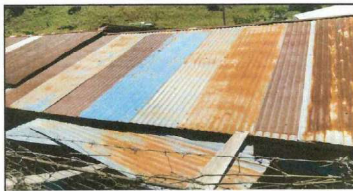
Foto 4: Sustitución de lamina acanalada en mal estado por lamina troquelada, en area de cocina y aula.
